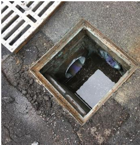
Figura 5 Pozzetto di ispezione
